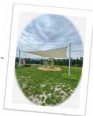
Das Segeltuch überdeckt einen Bereich von rund 25 m<sup>2</sup> und ist an vier großen Stahlsäulen gespannt. Die Säulen sind mit dicken Betonfundamenten im Untergrund verankert, um auch stärkeren Windböen standhalten zu können und bietet im Sommer einen idealen Sonnenschutz, für den bei kleineren Kindern beliebten Teilbereich mit Sandkasten. Ein herzliches Dankeschön an die ausführende Fachfirma sowie das Bauhof-Team für die Installation.
