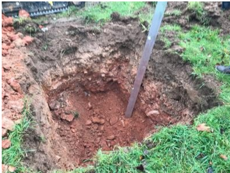
Abb. 1: Ausgehobener Schurf vor Einfüllen des Wassers.
