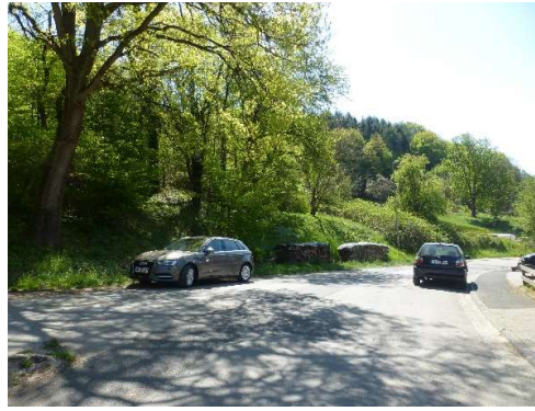
Böschung: Blick Ri Süden (Quelle: Foto Michael Maier / 22.04.2020)
