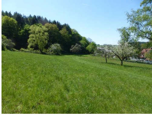
Böschung: Blick Ri Süden (Quelle: Foto Michael Maier / 22.04.2020)
