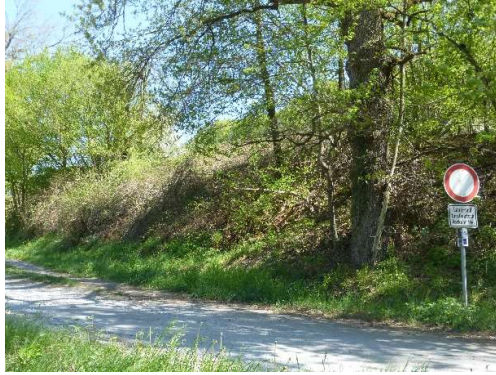
Böschung: Blick Ri Norden (Quelle: Foto Michael Maier / 22.04.2020)
