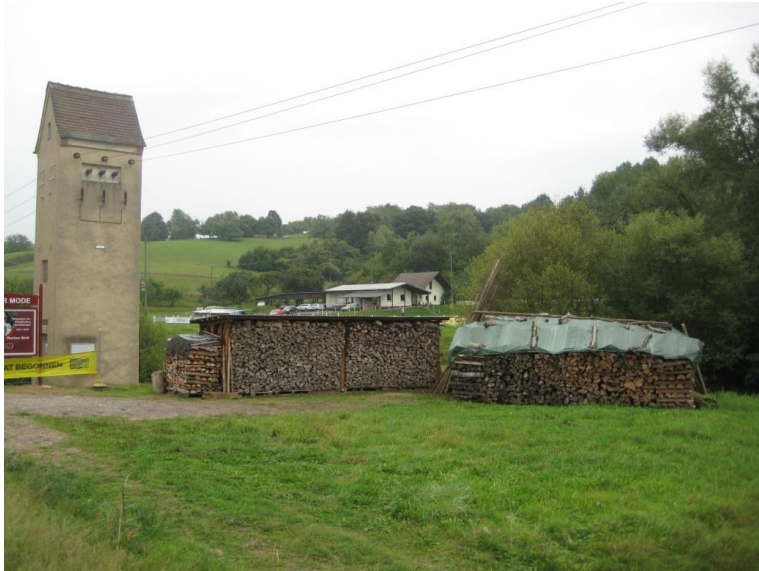
Das Plangebiet von Sulzbach kommend – rechts die anschließende Grünstruktur - im Hintergrund das Vereinsheim
