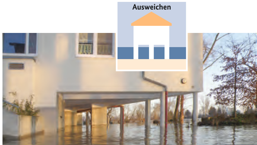
Ausweichen: zum Beispiel durch Aufständern von Gebäuden
