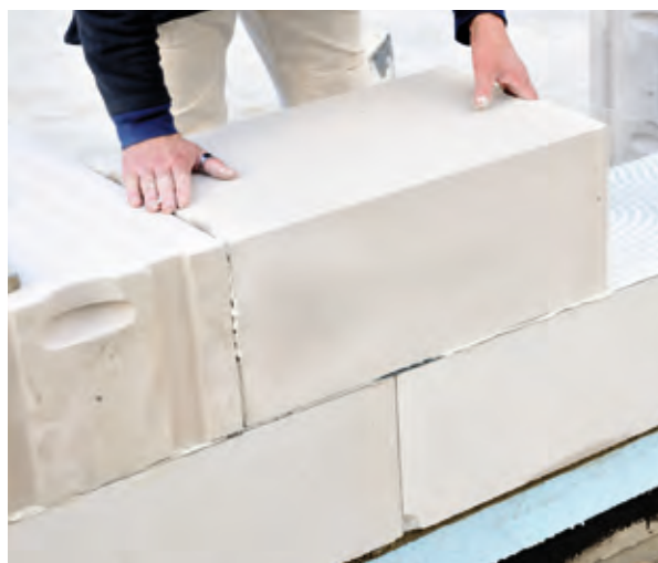
Mauerwerk aus Porenbeton
