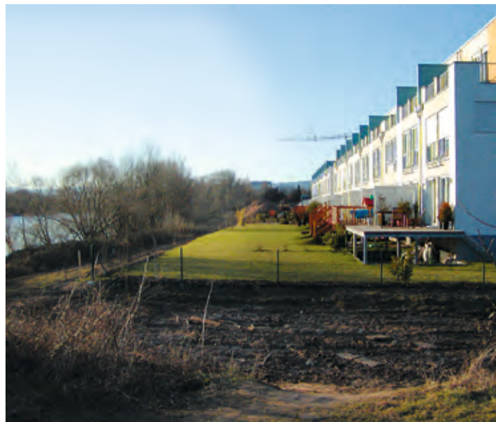
Hochwasserangepasste Bauweise mit erhöhtem Erdgeschoss
