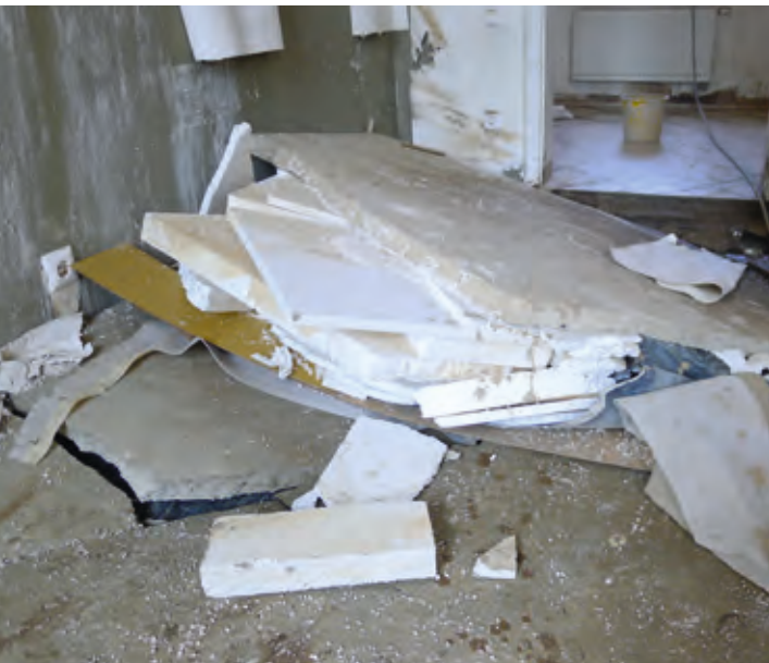
Aufgeschwommener schwimmend verlegter Zementestrich
