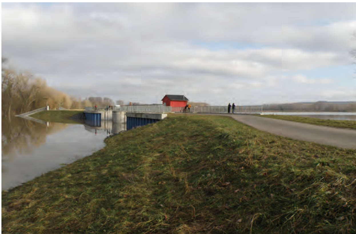
Polderflutung am Rhein bei Ingelheim
