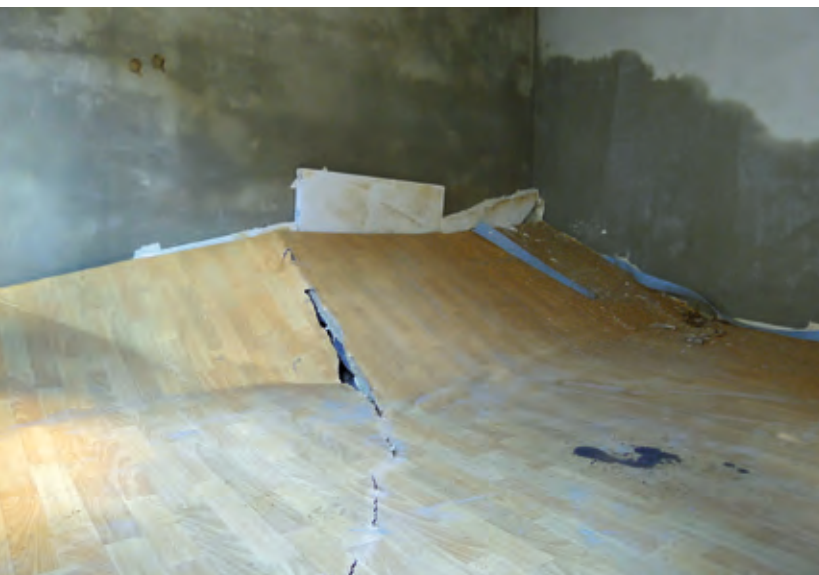
Aufgeschwommene Erdgeschossfußbodenkonstruktion
